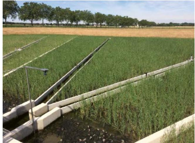
Abb. 8: Einbringen des Filtermaterials aus Filtersand und GAK mit einem Teleskopförderer (links) und der Filter nach Etablierung des Schilfauswuchses im August 2019 (rechts), im Bild ebenfalls zu erkennen sind die Trockenwetterrinnen.
